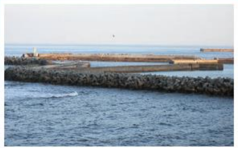
→いわき市四倉港防波堤灯台
